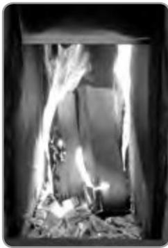
Haben Sie zusätzlichen Wärmebedarf, legen Sie max. 1-2 Scheite Brennholz nach. Andernfalls steigt die Abgastemperatur und der Wirkungsgrad Ihres Speicherofens wird verschlechtert. Die Nachlegemenge von 2kg/Std darf nicht überschritten werden.
